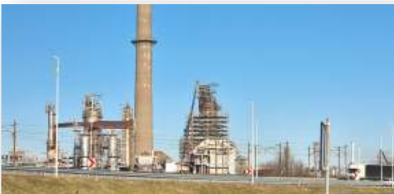
De crudetoren rechts naast de schoorsteen verdwijnt langzaam in de steigers tijdens de pre-tar werkzaamheden.
