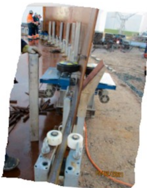
Met behulp van steunen met rollers worden de wand platen geplaatst
