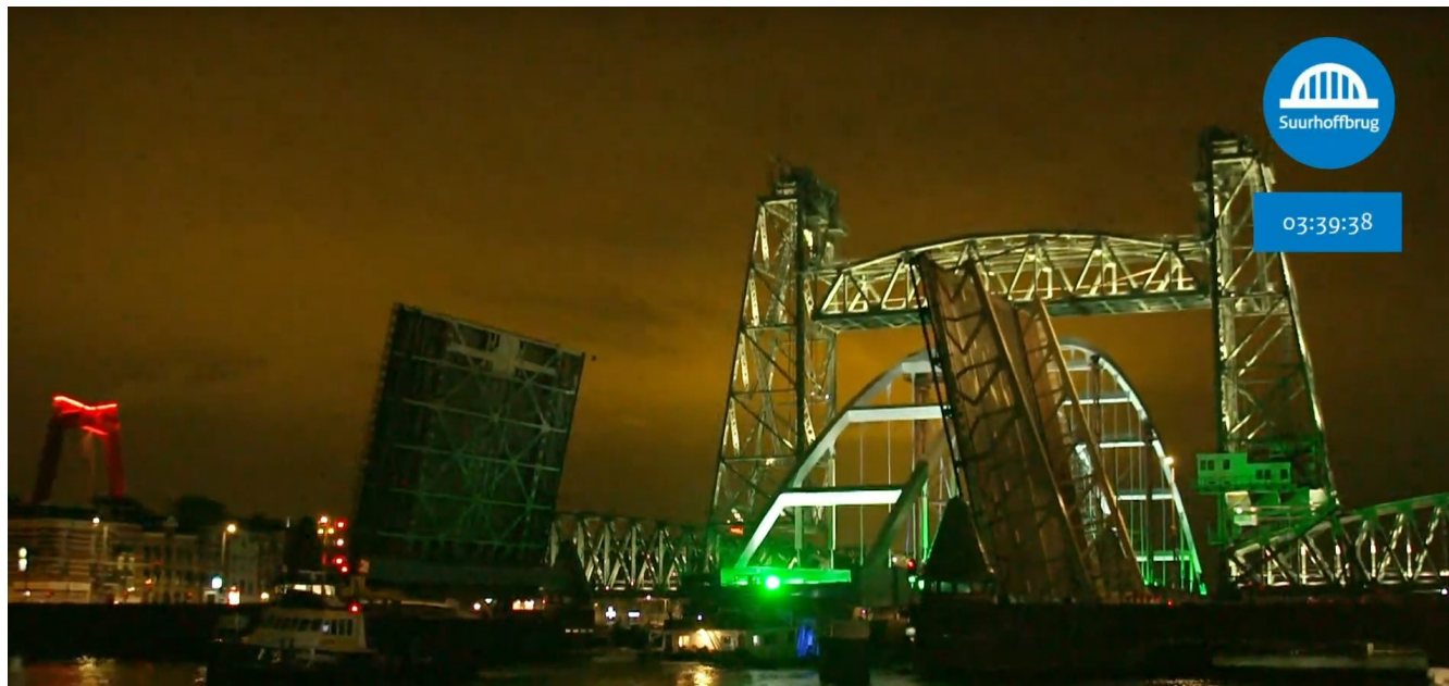
Passage van een boegbeeld van Rotterdam..."De Hef" - Koningshavenbrug
