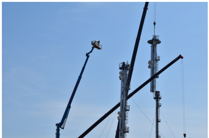
Plaatsing van het topdeel van de nieuwe, 65 meter hoge, flare 1 die met een koolwaterstof- en een sour gas tip is uitgerust
