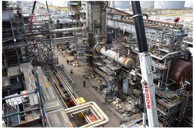
Een crude o/h warmtewisselaar wordt vervangen, 27 ton in de kraan
