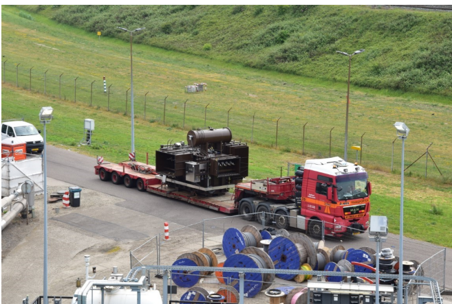
Sub station A werd voorzien van 3 nieuwe transformatoren, hier is er één op weg naar zijn bestemming.
