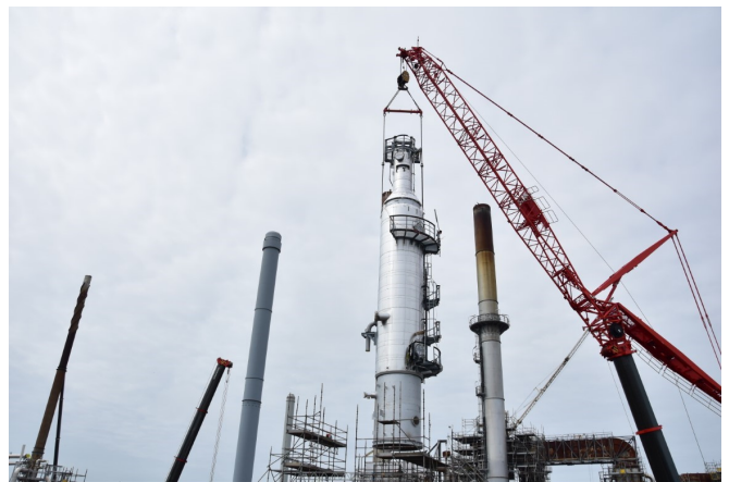
De nieuwe T801 wordt voorzichtig op zijn plaats gebracht met behulp van een 750 tons kraan....vakwerk!!!
