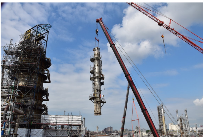
Zeer voorzichtig is de oude BPA toren tussen het steigerwerk uitgehesen. Een dag later wordt de nieuwe geplaatst.
