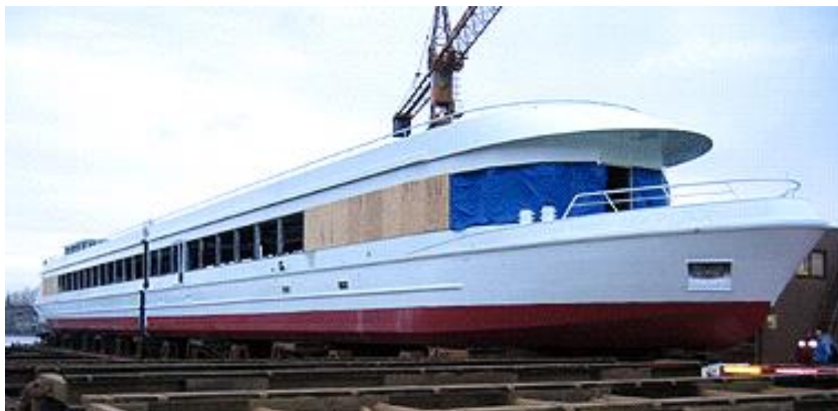
De Marlina in aanbouw.
